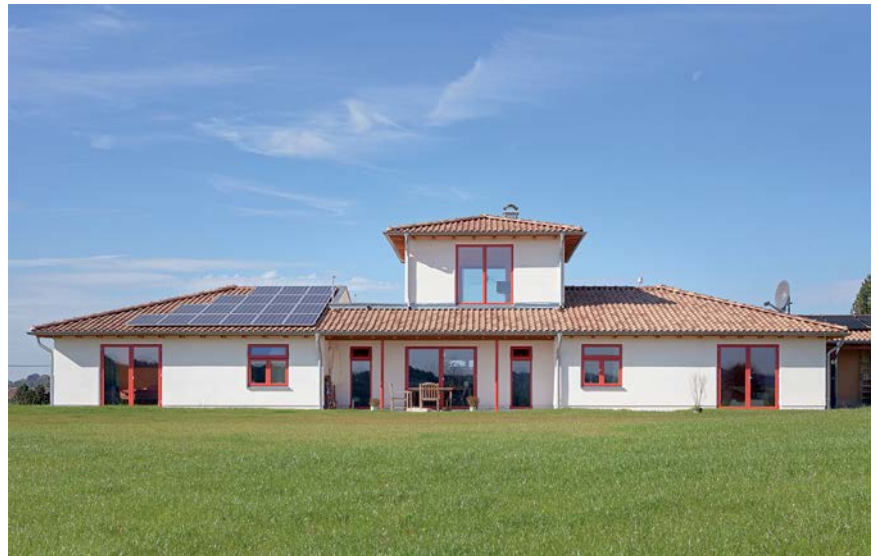
Lowtech Strohballendämmung und Hightech Eisspeicher mit Wärmepumpenheizung kombinieren Shakti Haus bei Ihrem neuen Wohnhaus im Kölner Raum
